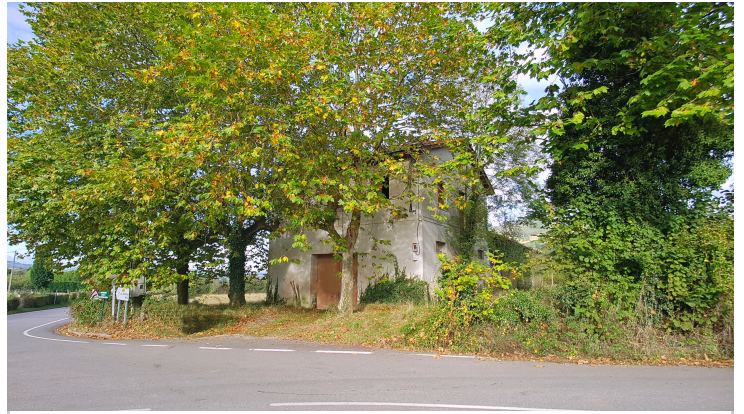
FACHADA Y ENTORNO
