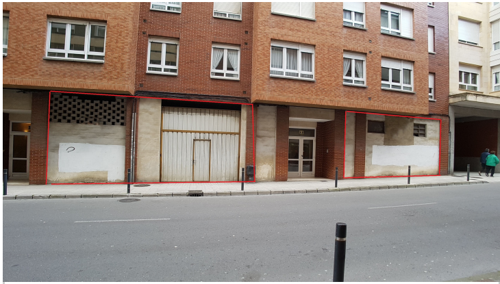
FACHADA DEL LOCAL
