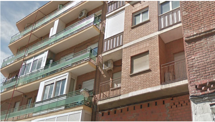
FRENT E EDIFICIO
