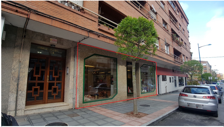
FACHADA DEL LOCAL
