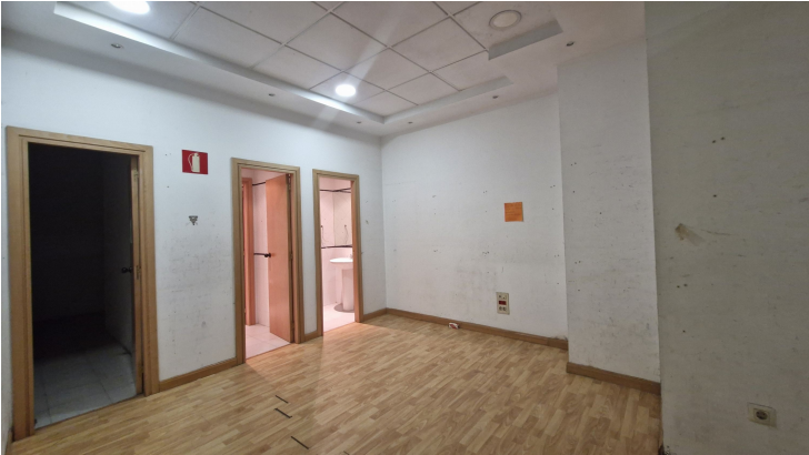
ALMACÉN O DESPACHO
